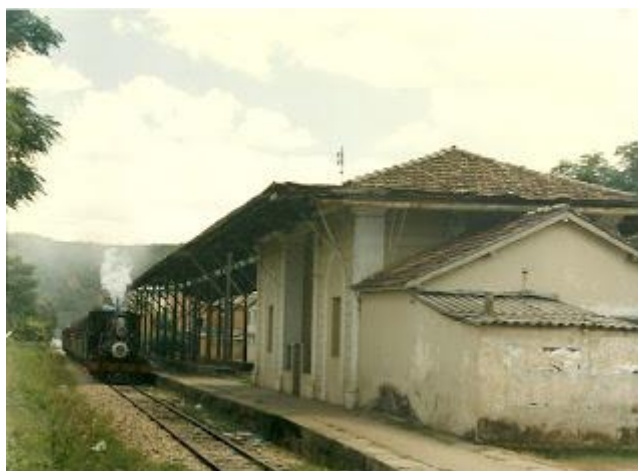
Estação de Chagas Dória em 1998, vendo-se na frente o acréscimo, que foi demolido na reforma de 2005.
