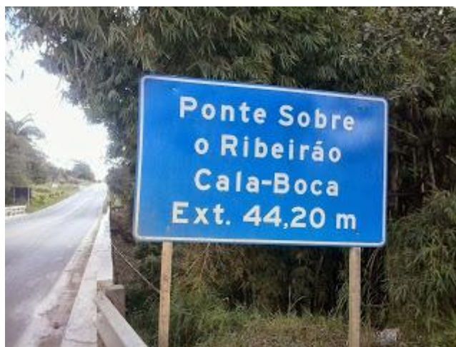
Placa na BR-265 nos arredores de São João del-Rei/MG.
