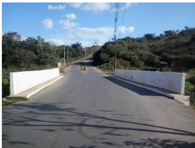
Ponte entre a Avenida Santos Dumont e a Vila Belizário. 11/08/2013.
