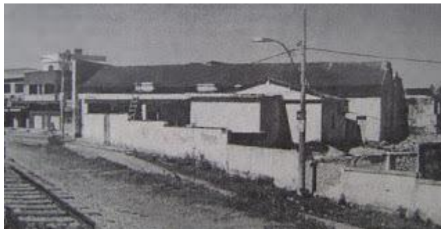
O matadouro de Matosinhos já em princípio de demolição. Foto: jornal O Grande Matosinhos
