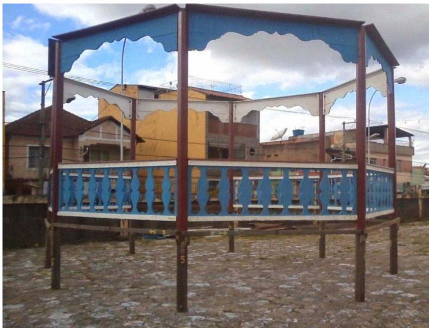
Coreto ainda em fase de montagem.
