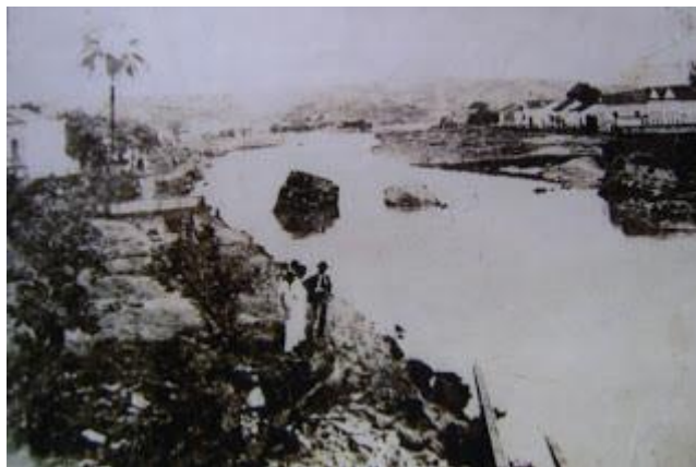
Enchente no Ribeirão da Água Limpa que arrasou a ponte. Autor: não identificado.
