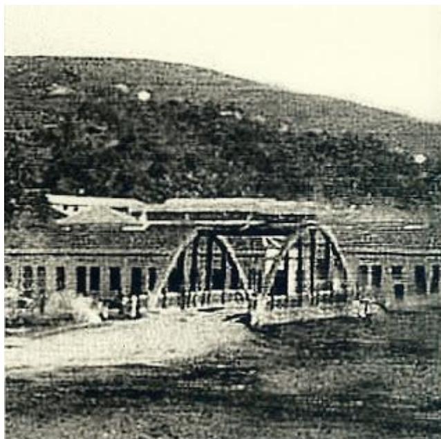
Ponte do Curtume.
