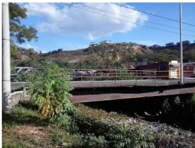
Ponte Beltrão, em 11/08/2013.
