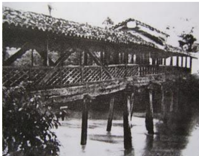
Primitiva Ponte do Porto. Foto de autor e data não identificados, gentilmente cedida para reprodução por Osni Paiva.
