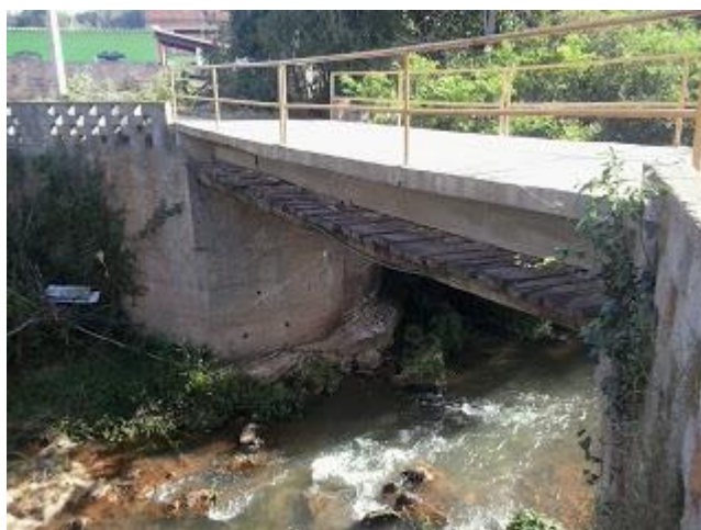
Ponte do Ouro Preto. Notar a ponte de concreto montada por cima da de madeira. 11/08/2013.
