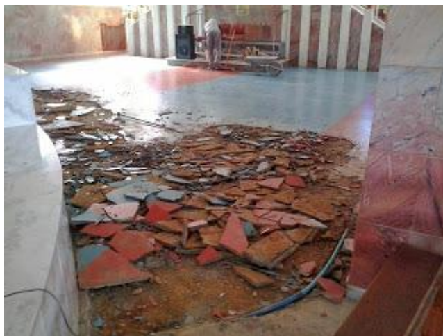
Piso antigo sendo removido.
